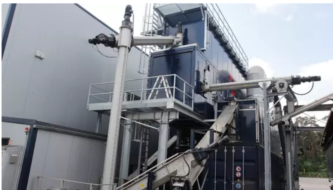
Bei dem Trocknersystem stehen mehrere Container übereinander. In dem oberen ist die Abluftreinigung enthalten. (Bildquelle: Neumann)
